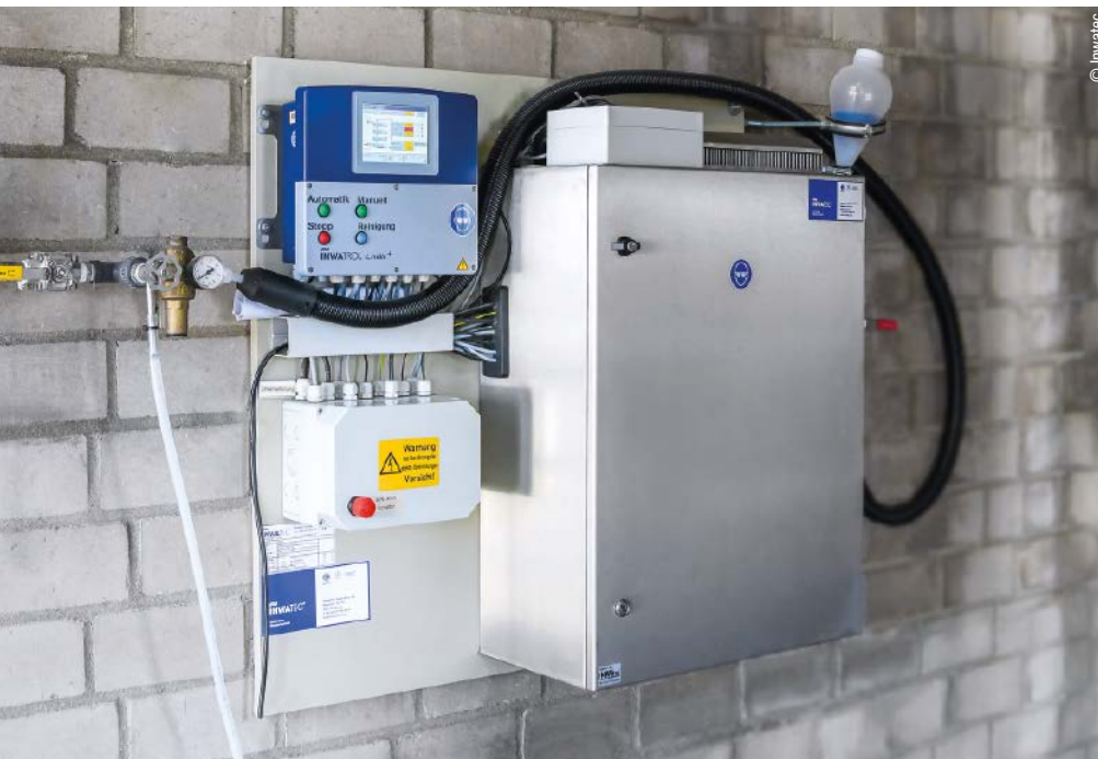
Abb. 3: Der Anlagenbetreiber kann gefahrlos und kontinuierlich die hygienische Wasserqualität ermitteln. Das Messgerät wird direkt an das technische Wassersystem mit automatischem und selbstdesinfizierendem Probeneinzug angeschlossen, einschließlich Selbstdesinfektion des in der Messzelle enthaltenen Wassers nach abgeschlossener Messung.
