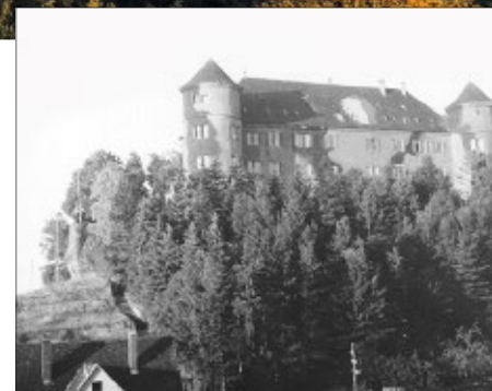
Diese Aufnahme vom Frühjahr 1946 zeigt das Schloss Hohenstein noch mit Tarnanstrich und Schäden, die durch Granateneinschläge verursacht wurden.
