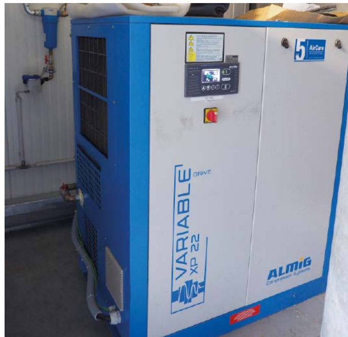
Abb. 2: Der Variable XP ist in Schwachlastphasen im Einsatz – z.B. nachts oder an den Wochenenden.
