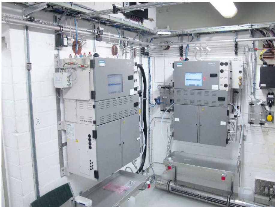
Systemintegration: Analysenhaus mit zwei Prozessgaschromatographen – optimiert für höchste Zuverlässigkeit bei flüssigen Probenströmen.
