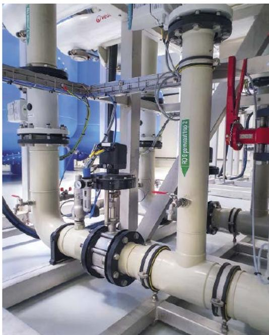
**Die präzise Durchflussregelung der Gleitschieberventile gewährleistet, dass jeder der acht Aktivkohlefilter (hier im Bild) und die 13 Remineralisierungstanks gleichmäßig ausgelastet werden.**
