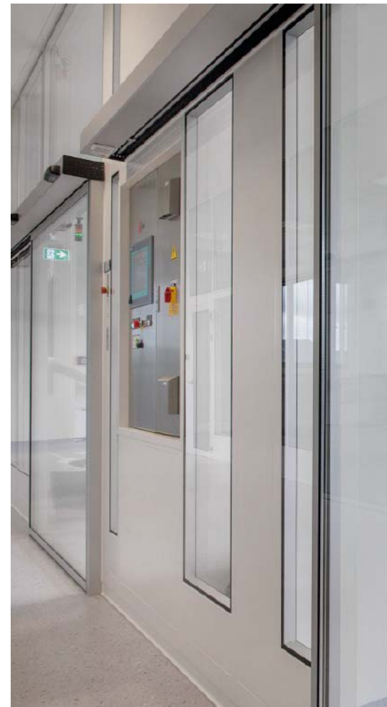
▼ Abb. 3: Reinraumgerechte Türeingebauten sind ein wichtiger Planungsaspekt. Sie entscheiden, ob Kontaminationen zuverlässig draußen bleiben. © Glatt
