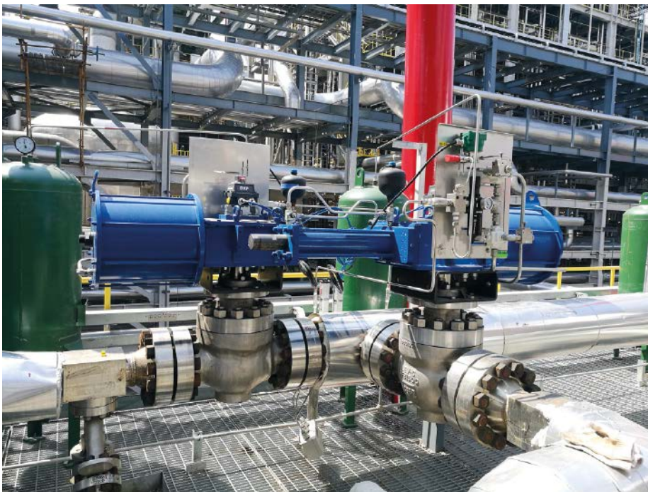
Abb. 3: Emerson AEV C-Ball Kugelhahn mit pneumatischem Scotch Yoke Antrieb.
