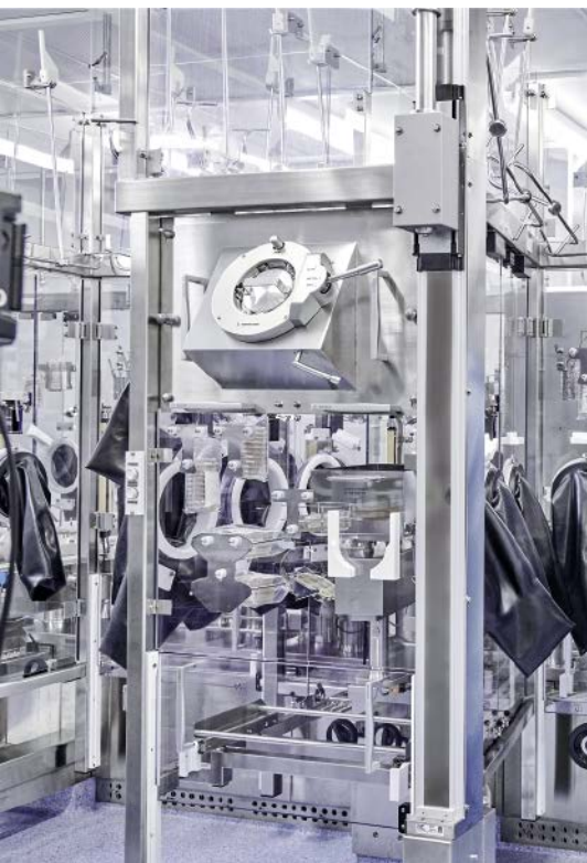
▲ Reinraumumgebung mit Port-System.
