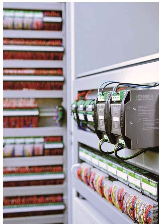
Abb. 2: Bei der neuesten Generation dreiphasiger Netzgeräte der Baureihe „Emparro“ von Murrelektronik konnte ein Wirkungsgrad von nahezu 95% bei Volllast realisiert werden.
