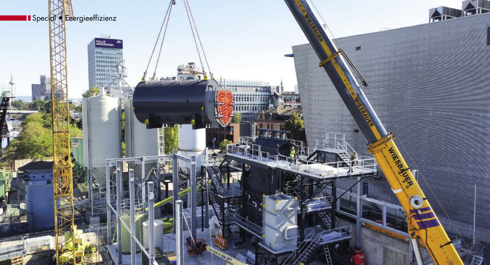
■ Abb. 1: Mit der Anlieferung des 25,5 t schweren und 14,3 m hohen Biomassekessels, wurde jetzt der erste wichtige Meilenstein des Großprojektes erreicht. Vom Produktionsort in Serbien war der Kessel mit Schwertransportfahrzeugen vier Tage unterwegs.
