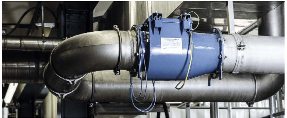
■ Abb. 2: Bei der Redex Flap handelt es sich um eine rein mechanische Explosionssenkungslösung, welche die Ausbreitung von Explosionen bei entgegengesetzter Strömungs- und Explosionsrichtung verhindert.
