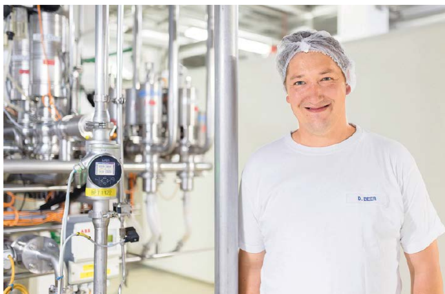
Abb. 2: „Das demineralisierte VE-Wasser hat nur eine sehr geringe Leitfähigkeit von unter 5 µs/cm. Die bisher von uns in der Produktionslinie eingesetzten magnetisch-induktiven Durchflussmesser waren dafür nicht geeignet“, so Danilo Beer, Teamleiter und stellvertretender Produktionsleiter Trocknung der Molkerei Hainichen-Freiberg.
