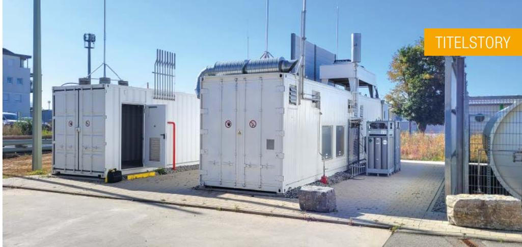
Die Anlagentechnik besteht aus dem Elektrolyseur (Mitte), der Mischanlage (links), dem Wasserstoff-Tank (rechts) und erdgedeckten Pufferspeichern (nicht sichtbar).
