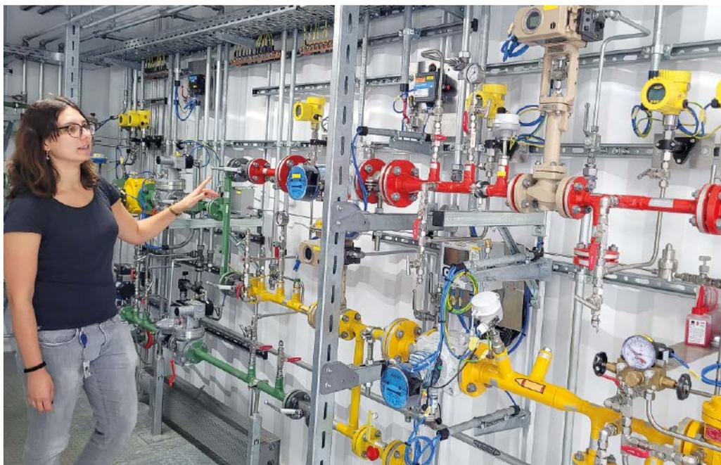
Daniela Wieland, Ingenieurin bei Netze BW, erklärt die Funktionsweise der Mischanlage, in der Wasserstoff dem Erdgas beigemischt wird.
