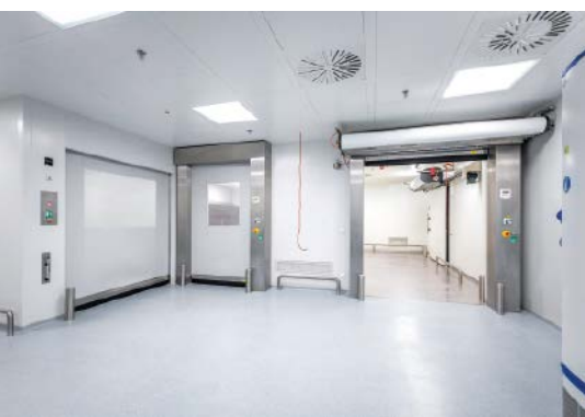
Abb. 3: Reinraumtaugliche Rolltore bieten bei häufigem Öffnen und Schließen eine sehr gute Alternative zu anderen Türsystemen
