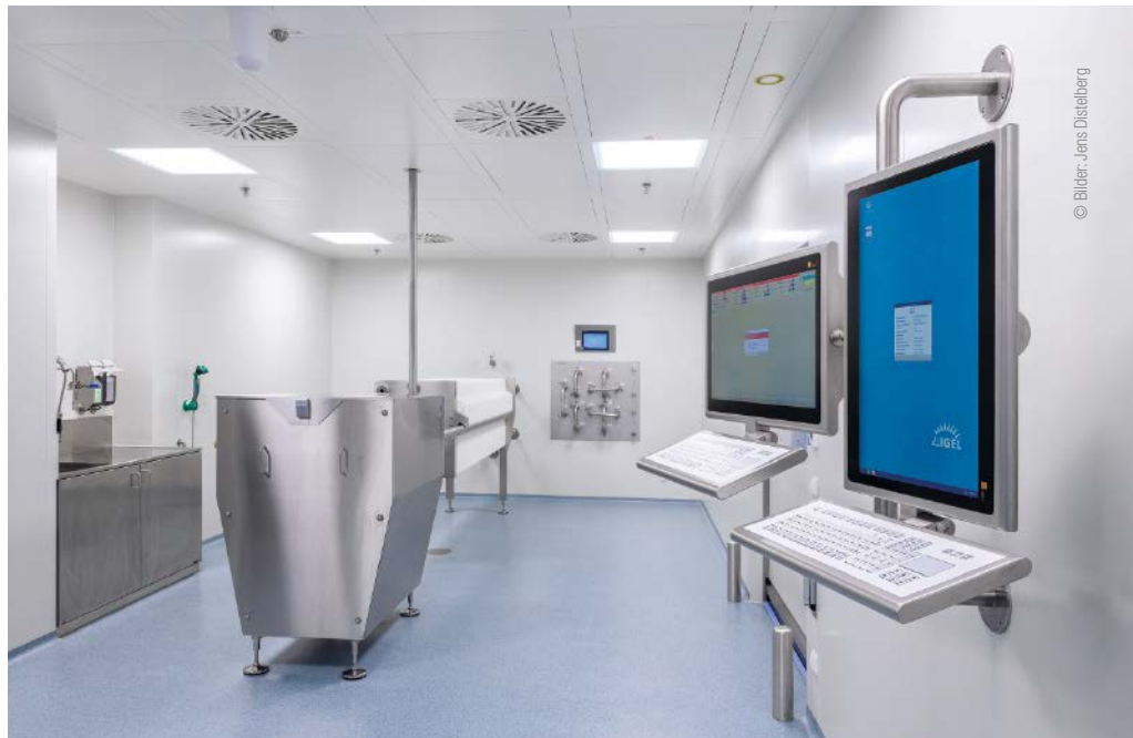
Abb. 2: Filterpresse im Reinraum einer Plasmafraktionierung: reinraumgerechte Integration aller Bedienelemente.
