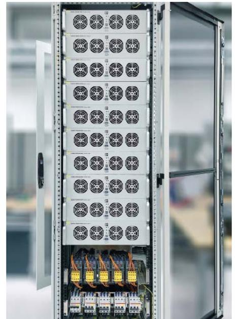
Standardisierter 19-Zoll-Schaltschrank zur Versorgung eines Elektrolysemoduls
